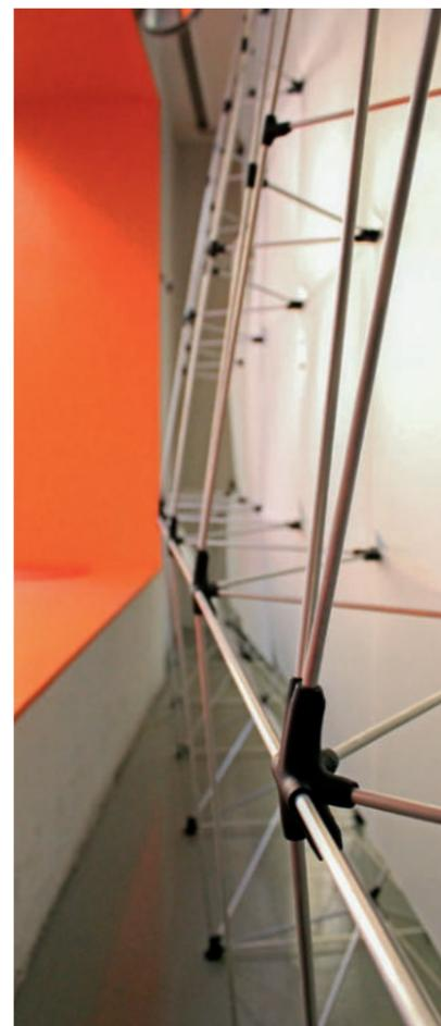
Schaufenster verstellen musste.« Den benötigten Sichtschutz entwarf Henrich selbstredend am eigenen Laptop: Milchig-transparente Kunststoffblätter hängen an einem filigranen Gestell aus dünnen Metallstangen und schwarzen, 3D-gedruckten Verbindungsstücken. Auf einer ähnlichen, selbst entworfenen Konstruktion ruht die schwarze Platte seines eleganten Schreibtischs.
